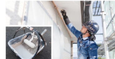
◆外壁塗装に使うローラーと刷毛 細かい部分は刷毛で丁寧に仕上げています
